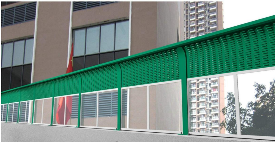
图 6.2-2 直立式声屏障工程实例图
