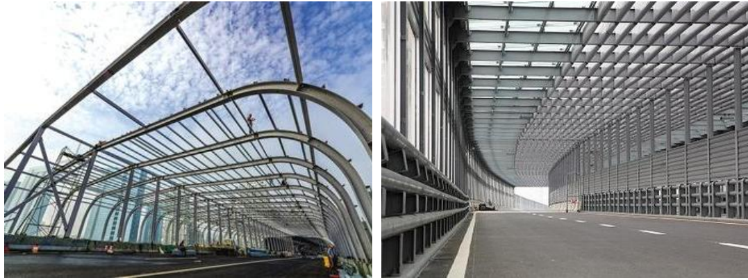
图 6.2-3 全封闭式声屏障工程示例图
